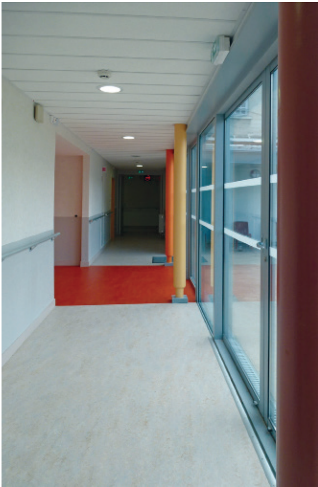
Détail de la façade
