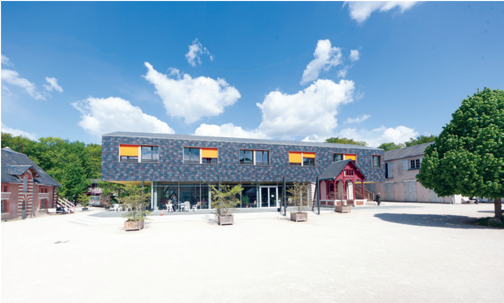
Extérieur du bâtiment côté cours
