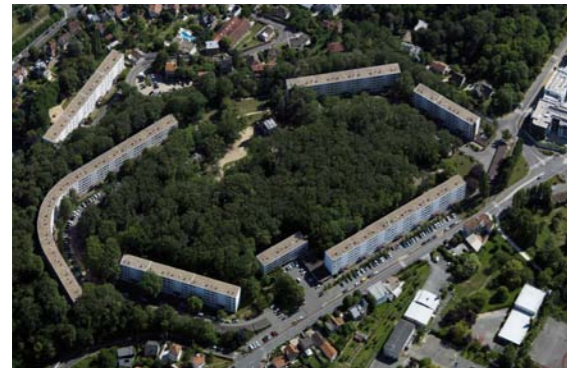
Ensemble de 395 logement à la situation exceptionnelle
